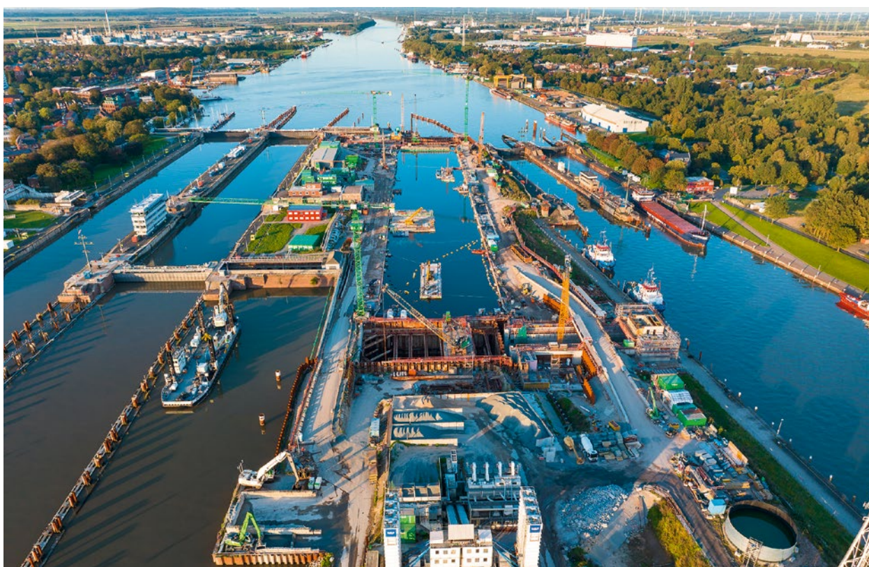
Abbildung 53 Bau der 5. Schleusenammer Brunsbüttel/Nord-Ostsee-Kanal Foto: WSV
