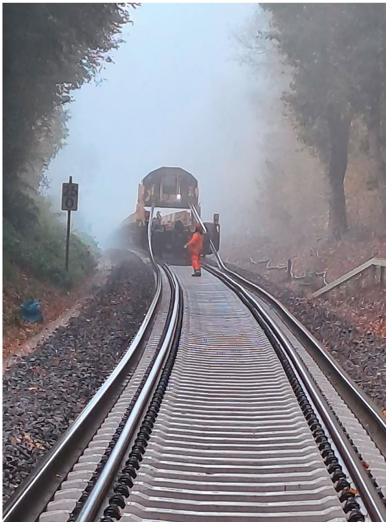
Abbildung 12 Schienenverlegung Foto: N. Spindelman
