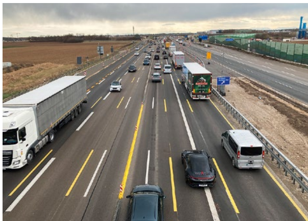
Abbildung 31 Baustellenverkehrsführung auf der A 99
