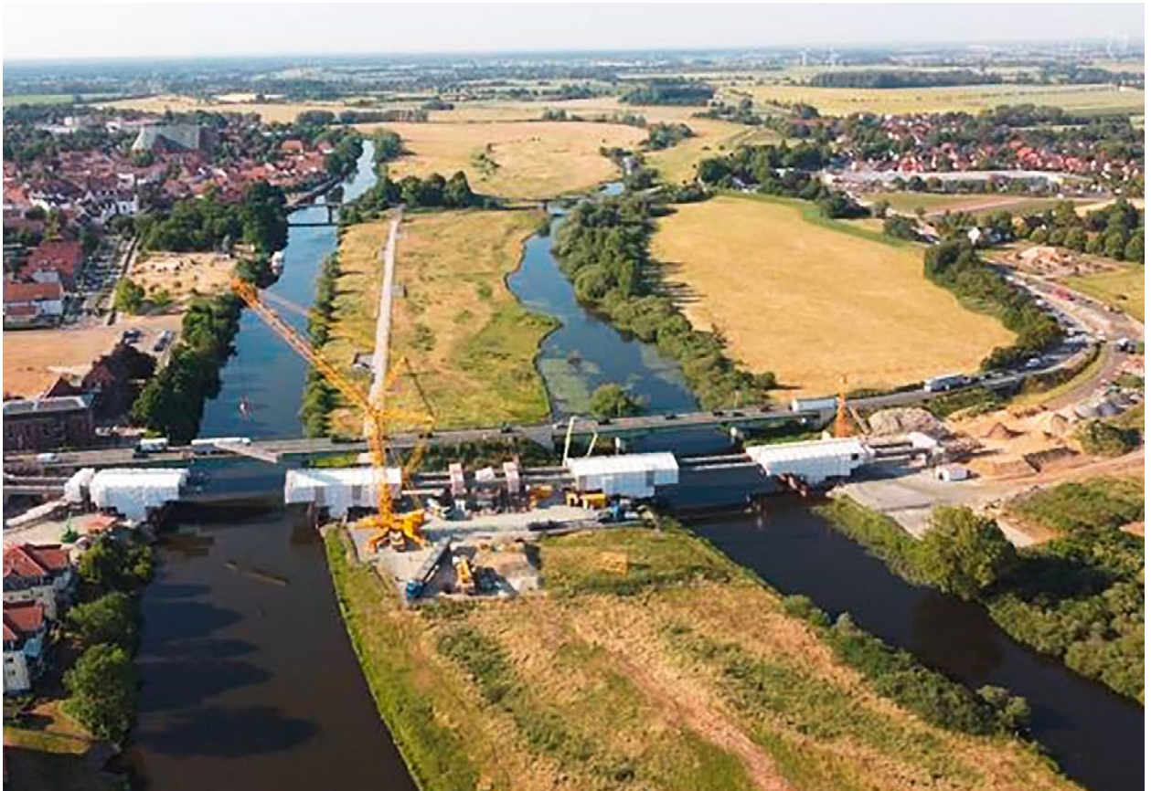
Abbildung 41 B 215, Allerbrücke Verden
