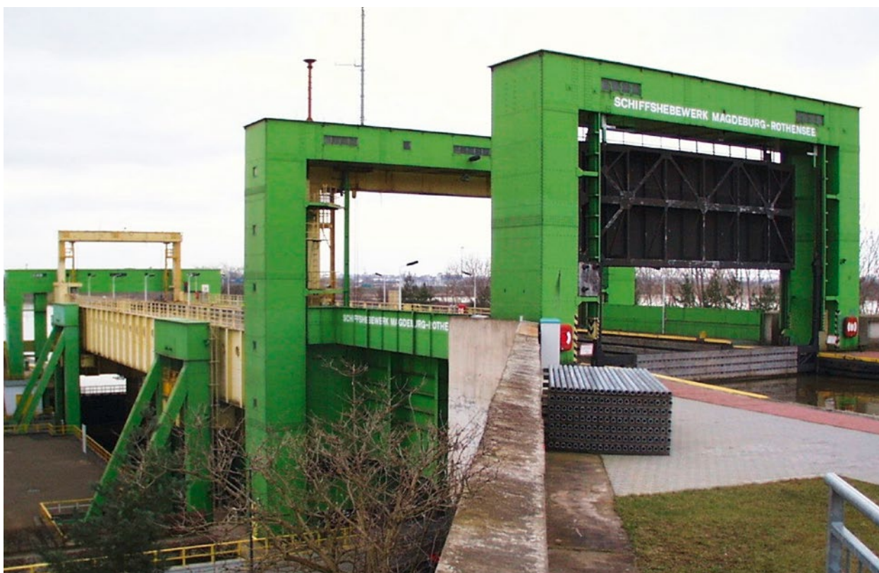
Abbildung 55 Schiffshebewerk Rothensee/Mittellandkanal Foto: WSV
