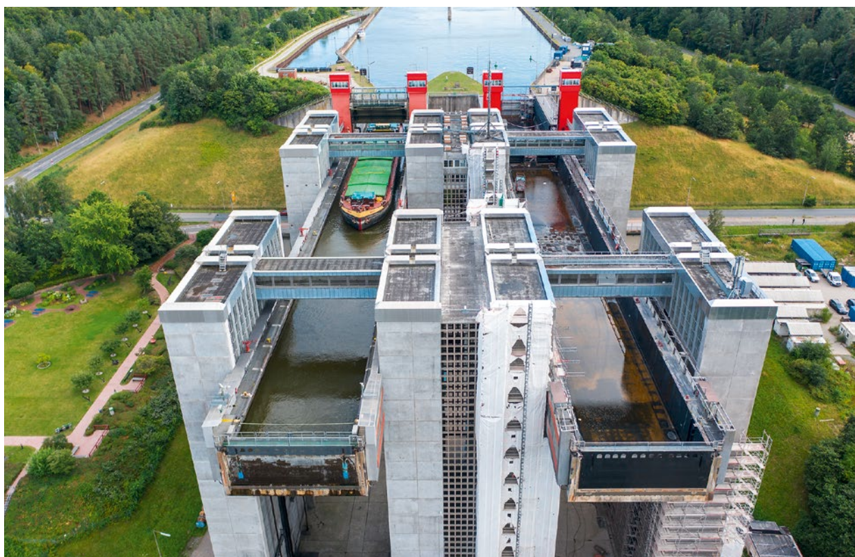
Abbildung 57 Sanierung Schiffshebewerk Lüneburg-Scharnebeck/Elbe-Seitenkanal Foto: WSV
