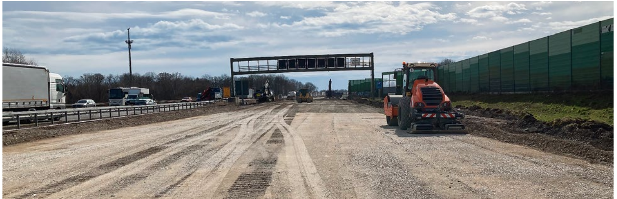
Abbildung 30 Baustelle auf der A 99
